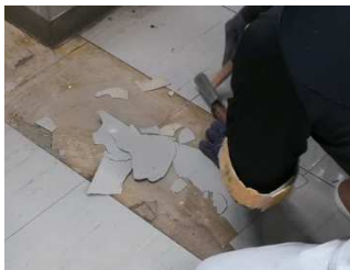
床タイルがし工事や ボルト止めの穴あけ工事
