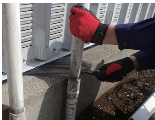
配管の改修、撤去工事
