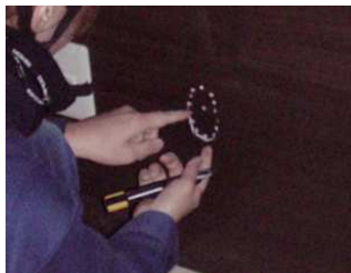
埋込コンセント増設の為の 壁の開口工事
