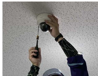
天井ヘカメラや無線アンテナ などの取付工事
